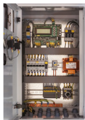
Q3E - ТРЕХФАЗНЫЙ ЭЛЕКТРО-РАСПРЕДЕЛИТЕЛЬНЫЙ ЩИТ ДЛЯ ЕС-ВЕНТИЛЯТОРОВ 400V-3-50HZ
